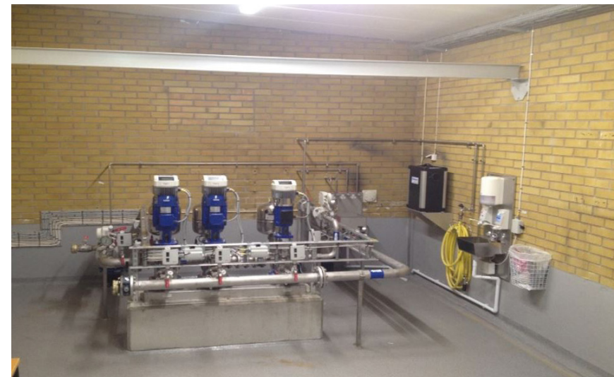
Ombyggnad av tryckstegringsstation för dricksvatten (2015).
