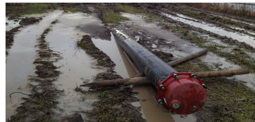
Spillvattenledning renoveras med flexibelt foder (2016).
