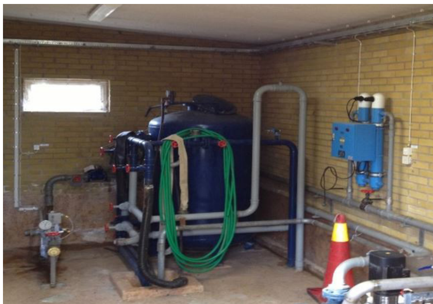
Ombyggnad av tryckstegringsstation för dricksvatten (2015).
