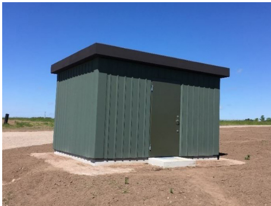
Ny överbyggnad till brunn för råvatten (2017).
