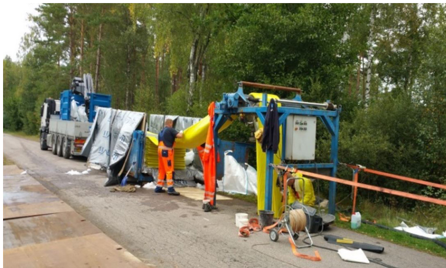
Spillvattenledning renoveras med flexibelt foder (2016).
