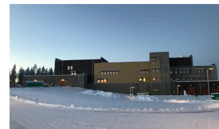
Skellefteå nya vattenverk under uppbyggnad i december 2018.
