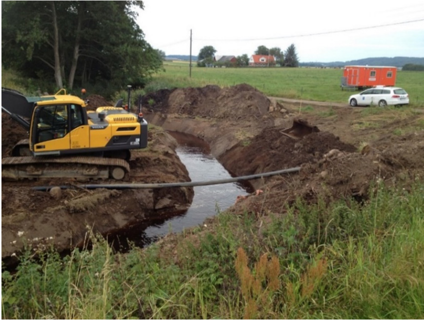
Anmälan om vattenverksamhet för att tillfälligt leda om bäck vid ledningsdragning under en bäck.
