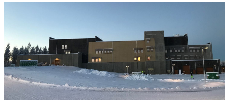
Skellefteås nya vattenverk (2018).
