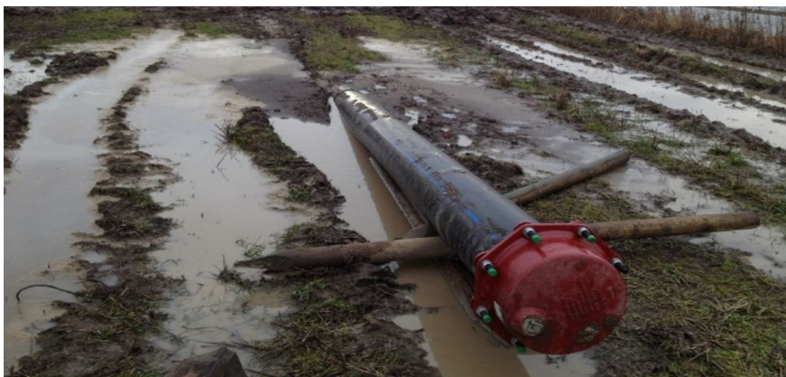
Spillvattenledning renoveras med flexibelt foder (2016).
