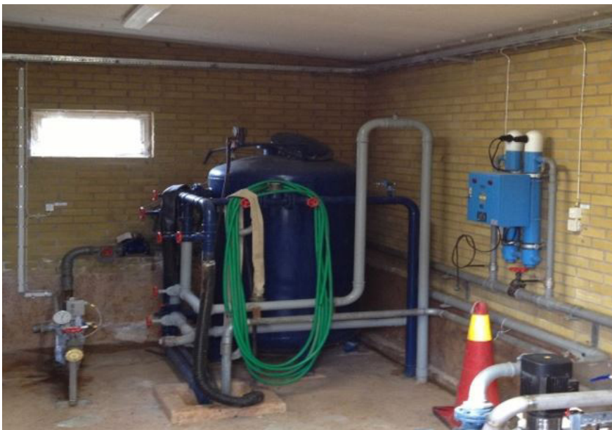
Ombyggnad av tryckstegringsstation för dricksvatten (2015).
