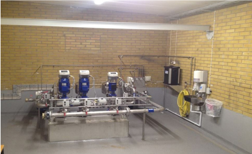
Ombyggnad av tryckstegringsstation för dricksvatten (2015).
