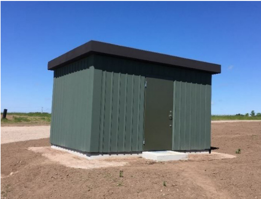
Ny överbyggnad till brunn för råvatten (2017).
