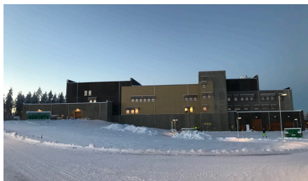
Skellefteå nya vattenverk under uppbyggnad i december 2018.
