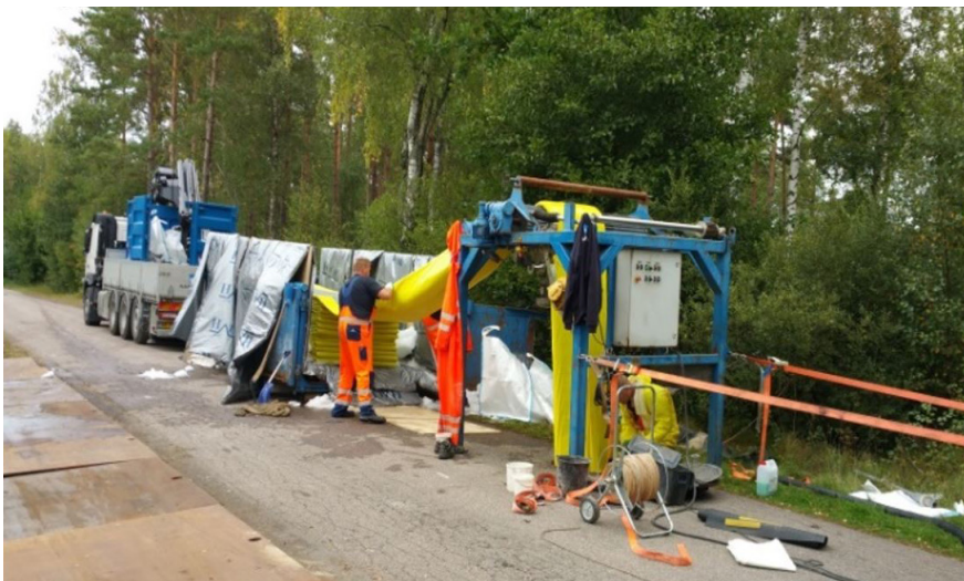
Spillvattenledning renoveras med flexibelt foder (2016).
