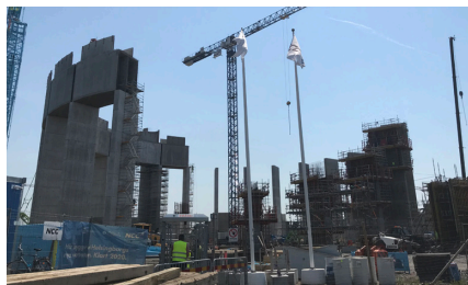
Helsingborgs nya vattentorn under uppbyggnad i maj 2019.
