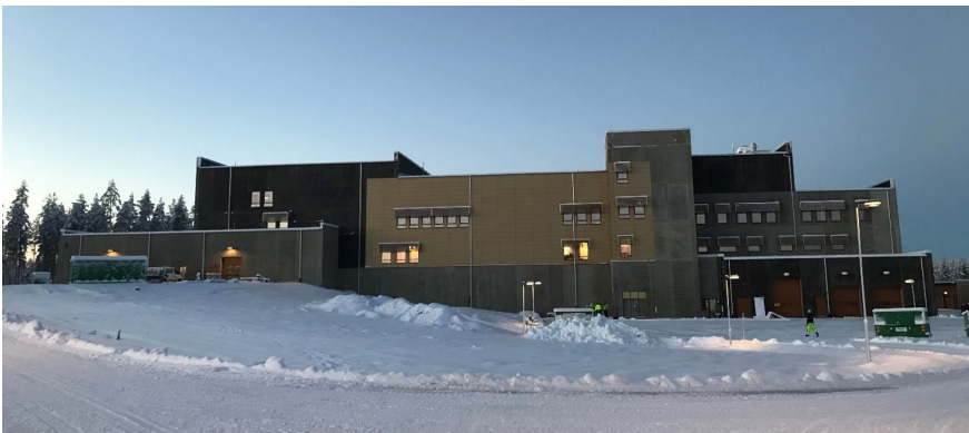
Skellefteås nya vattenverk (2018).
