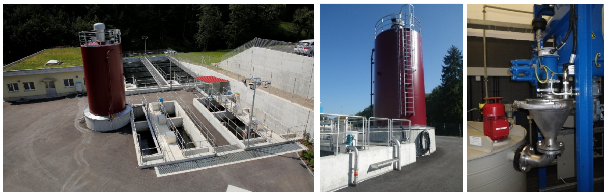
Figur 12. PAK-dosering enligt die Ulmer-Verfahren. I förgrunden (vänstra bilden) syns kontaktreaktorerna. Det gula huset rymmer verkets sandfilter. Till höger om detta hus syns sedimenteringsbassängerna. Bilden i mitten visar silon för lagring av PAK. Bilden till höger visar vätnings och doseringsutrustningen som ryms under silon.
