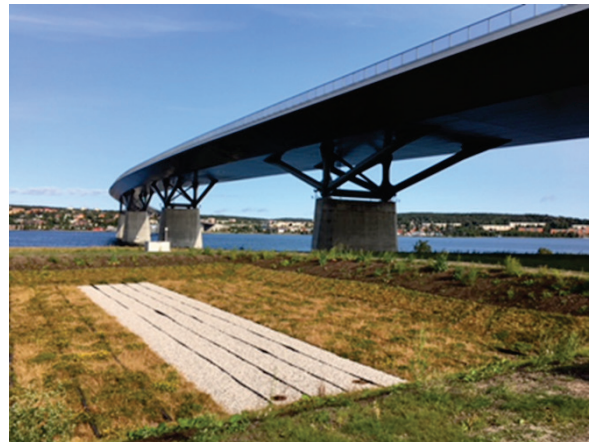
Figur 12. Biofilteranläggningen i Sundsvall.
