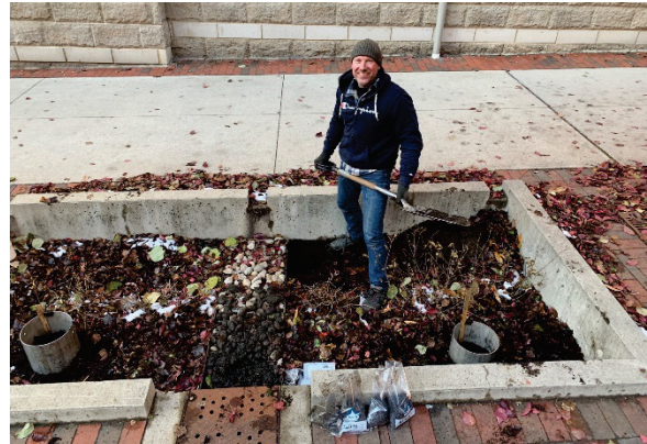
Figur 13. Provtagning av filtermaterial på biofilteranläggning.
