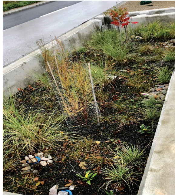
Figur 24. Nyanlagt biofilter för dagvattenhantering i Malmö.
