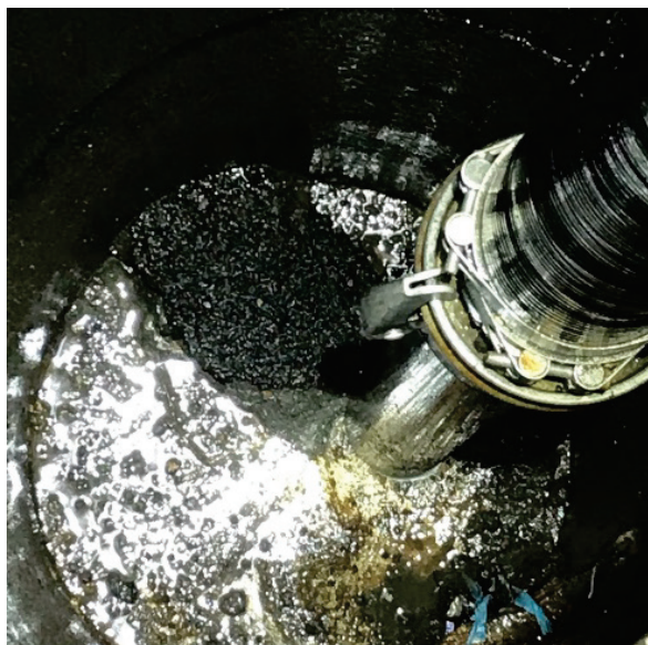
Figur 21. Emulgerad grovkornig asfalt fanns i många dagvattenbrunnar.
