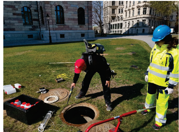
Figur 17. Provtagning vid zeolitfiltret som är anlagt nära museets huvudbyggnad – Nationalmuseum på Blasieholmen, Stockholm.
