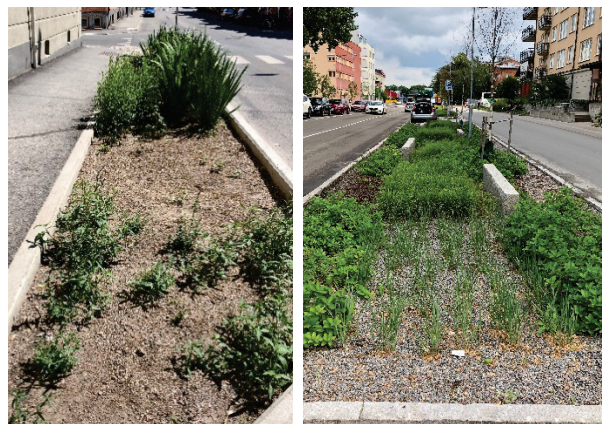
Figur 14. Exempel på biofilter med undermålig (vänster) respektive godtagbar (höger) vegetation
