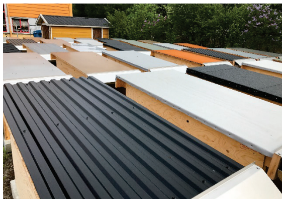
Figur 5. Pilottak med olika byggnadsmaterial vid LTU.
