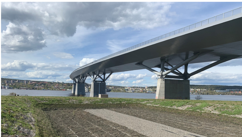
Figur 3.1 Anläggningen i Sundsvall med två växtbevuxna sektioner och ett icke-växtbevuxet sandfilter i mitten. E4-bron syns i bakgrunden.
