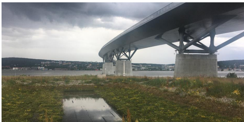
Figur 3.4 Tillfällig magasinering på filterytan efter regn.
