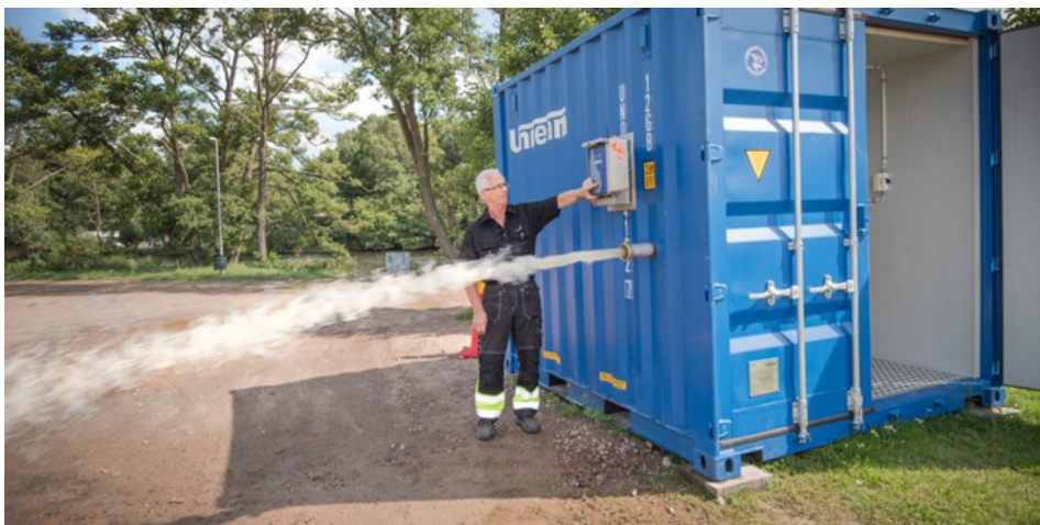
Driftteknikern Gert Bengtsson visar den nya vattenkiosken. För att tanka kopplas en slang till uttaget. Bild: Jari Väliälo.
