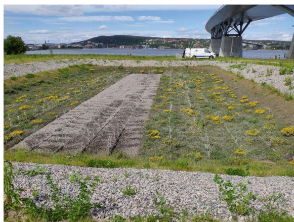
Figur 12. Anläggningen i Sundsvall består i sandfilter utan vegetation och biofilter med vegetation.
