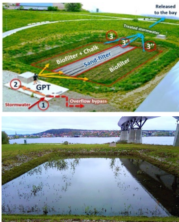
Figur 14. Flerstegsrening av dagvatten i en biofilteranläggning med försedimentering i Sundsvall, före och strax efter ett nederbördstillfälle.
