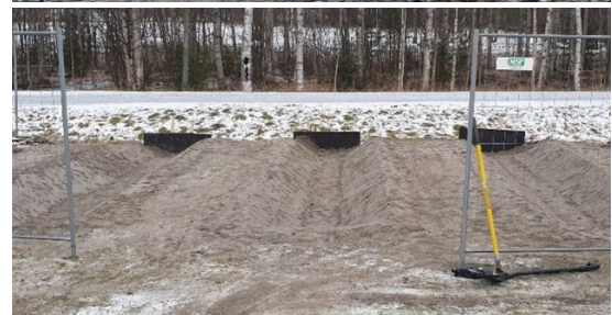
Figur 25. Testsite Luleå – fullskalig anläggning, Storheden (bild ovan) och pilotanläggning vid universitetet (bild nedan).
