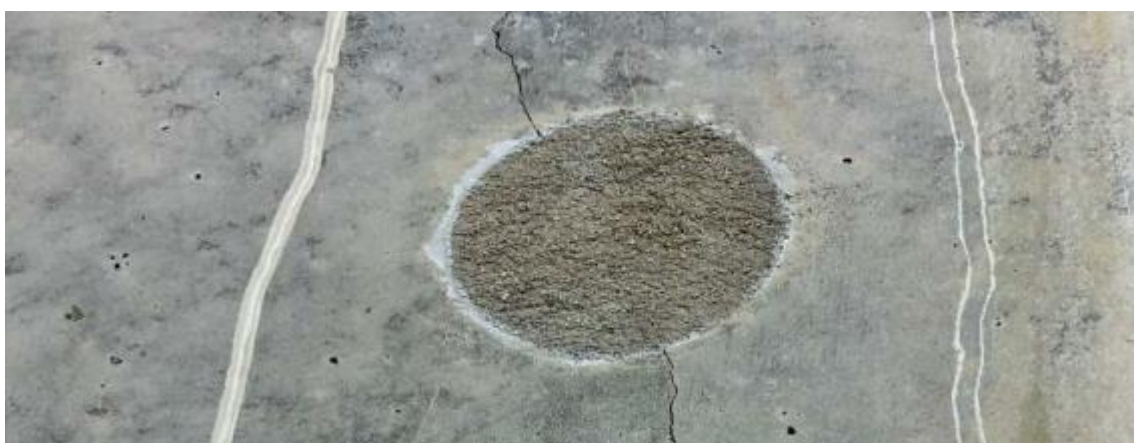
Bild på igengjutet formstag. Sprickor syns i anslutning, en risk som bör beaktas.
