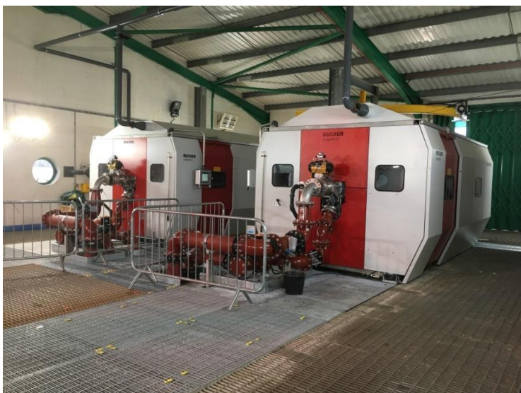
Figur 3. Hydrauliska kolvpressar av typ "Buchser HPS".
