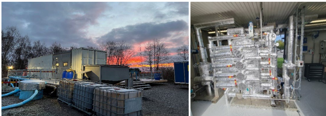
Figur 4. C-Greens HTC-pilotanläggning på plats i Margretelunds ARV. I förgrunden på den vänstra bilden visas mottagningsfickan för slam. Till höger visas pilotanläggningens HTC-reaktor (bilderna är tagna i Margretelund november 2021).
