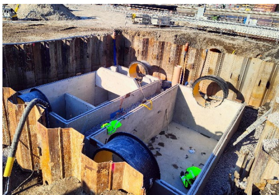
Figur 14. Dagvattenreningssteget under uppförande.
