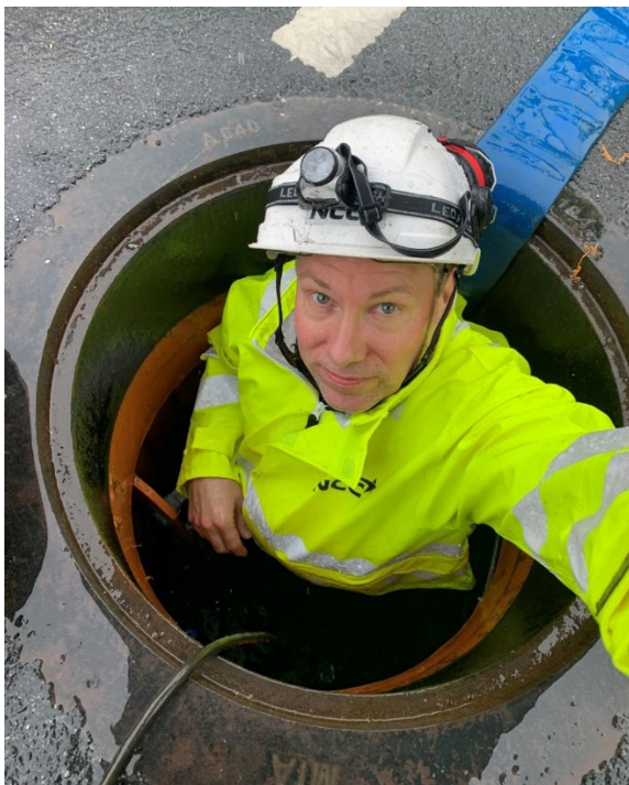
Figur 11. Kalibrering av utrustning inför provtagning av dagvatten i biofilter.
