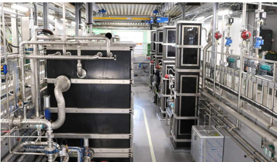
Figur 13.2 MBR-GAK-pilotanläggningen vid Himmerfjärdsverket med membrantankar till vänster och de fyra GAK-filtren till höger.
