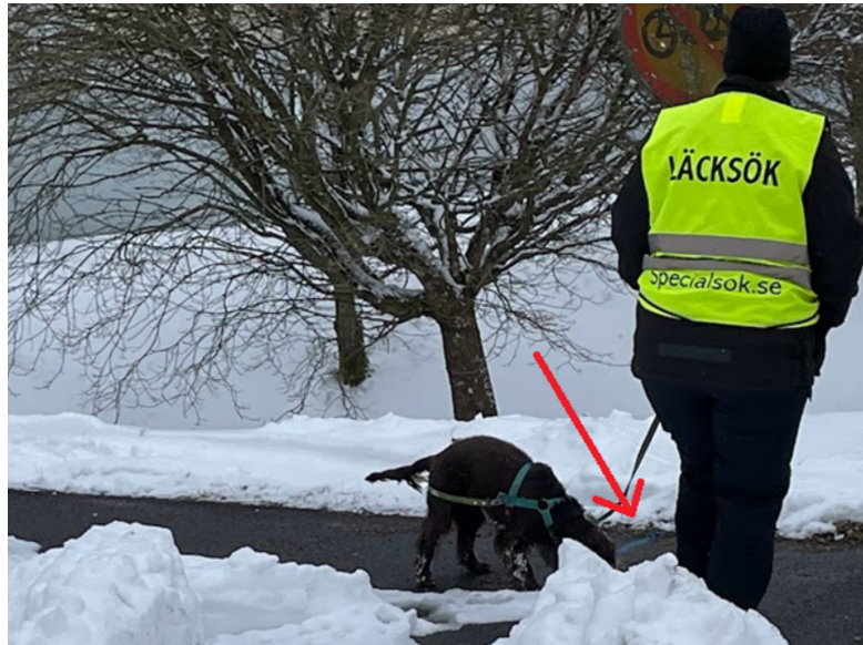
Figur 12: Läcksökning där hundföraren med läcksökningshund är ute på läcksökningsuppdrag. Hunden markerar var läckan är belägen.
