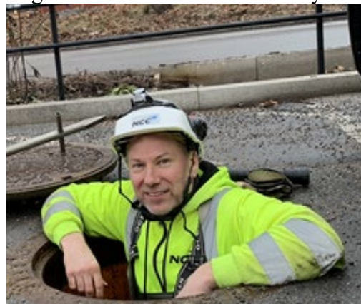
Bild 4. Provtagning av dagvatten från biofilter.
