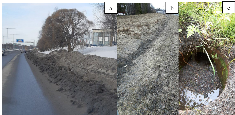
Bild 3: (a) Svackdiken som användes för avledning av dagvatten och lagring av snö, (b) svackdike i Luleå, efter snösmältning mid-april, (c) grus i dikets utloppsbrunn.
