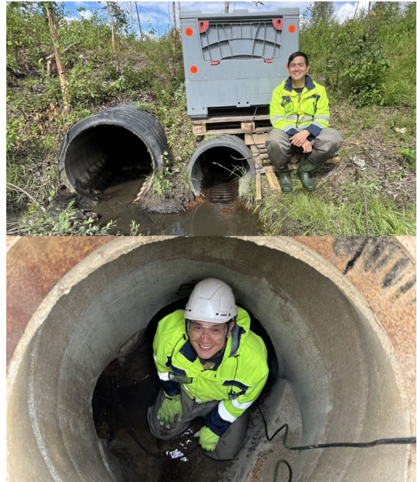
Bild 20. Installation av flödessensorer i urbant avloppsnät i Luleå.
