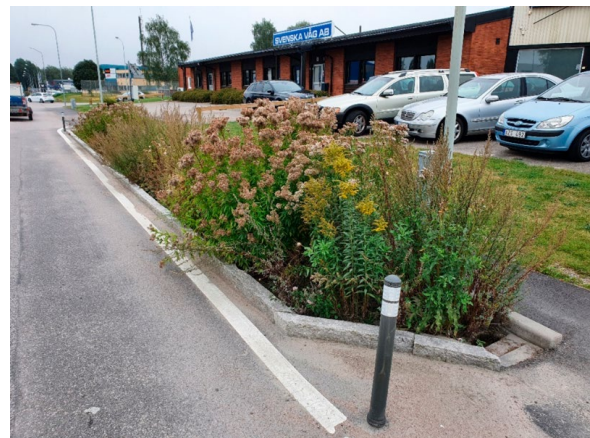
Bild 9. Biofilter i Växjö.
