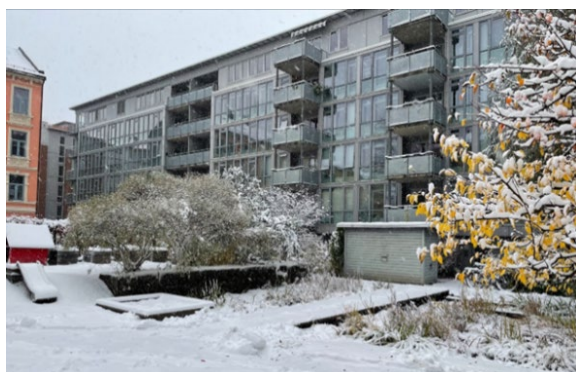
Bild 24. Konstruerad våtmarkssystem för rening av källsorterat BDT-vatten i Klosterenga, Oslo, januari 2024.
