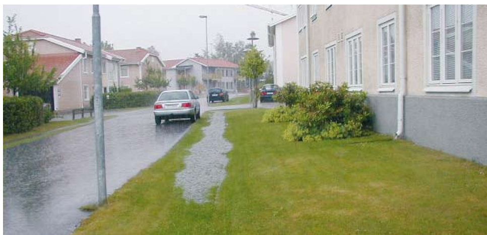
Nederbördssituation i Kampenområdet, Växjö, där dagvattenhanteringen byggts ut med LOD-tekniken. Regnet hade en återkomsttid på ca 10 år. (Foto: Göran Lundgren)
