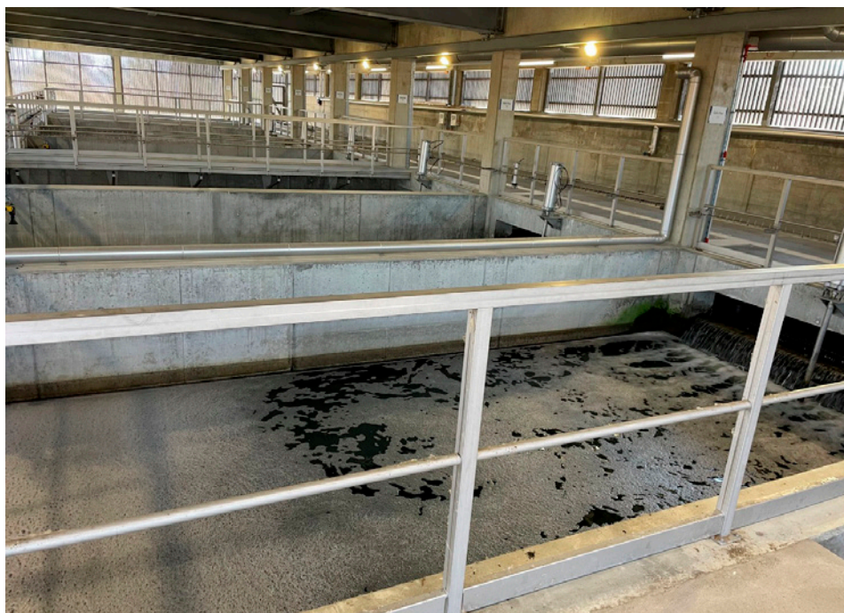
Figur A.12 Anläggning med GAK-filter på ARA Altenrhein.
