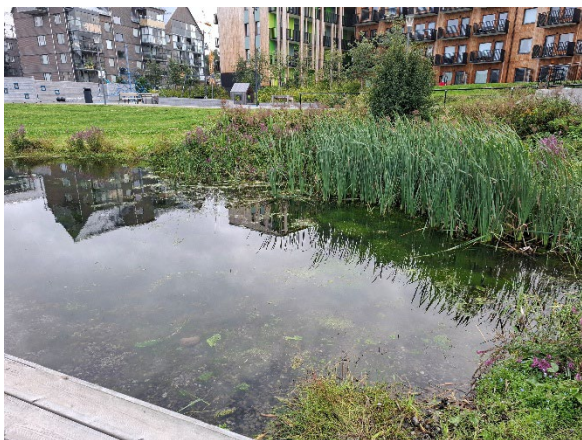
Bild 3. Dagvattendamm för hållbar dagvattenhantering i bostadsområde i Luleå.
