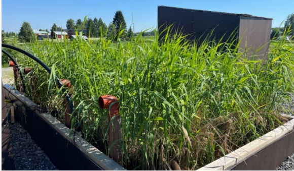
Bild 10. Pilotvassbäddsanläggningen för avloppsvattenrening, en så kallat ”fransk” våtmark.
