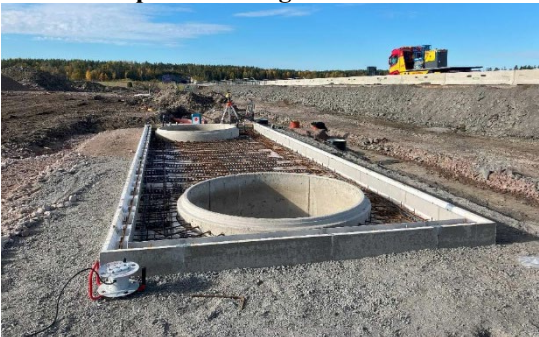
Bild 6. Pågående byggnation av testsektion vid E18.
